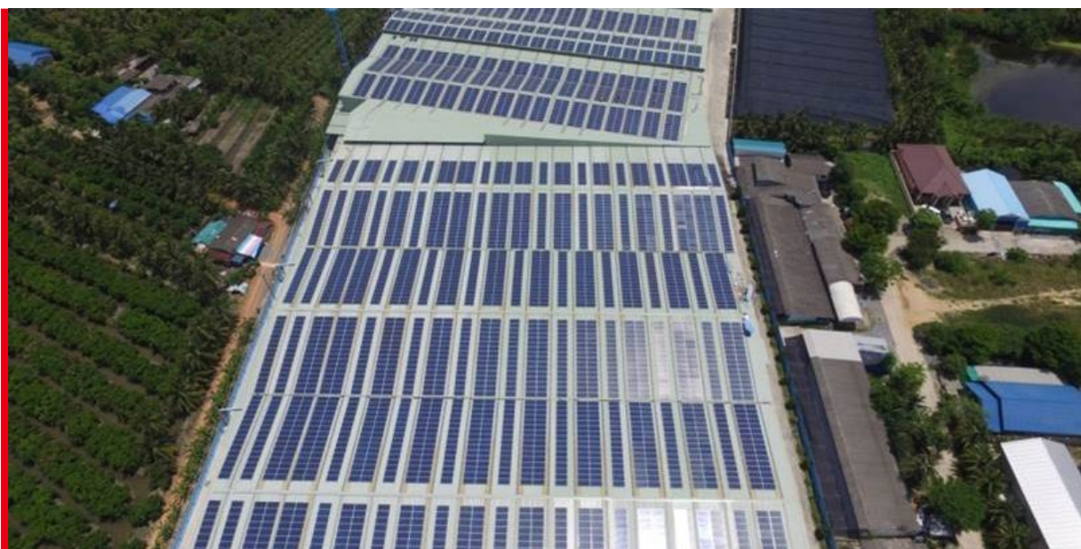
Dachowa elektrownia fotowoltaiczna o mocy 2 MW, generująca energię w systemie rozproszonym dla fabryk w Bangkoku w Tajlandii
